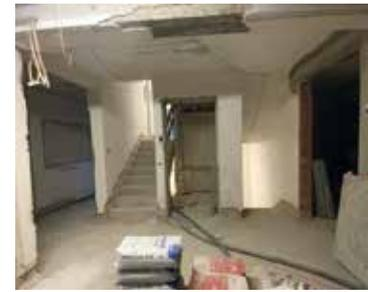
**Links:** Am Eingang ist eine neue Rampe ohne Treppe. **Rechts:** Der Fahrstuhl wurde entfernt und wird zugemauert. Das Fenster, wo sich der Saal befindet, wurde zugemauert. Die Wand an der rechten Seite wurde für einen Durchgang abgerissen.
