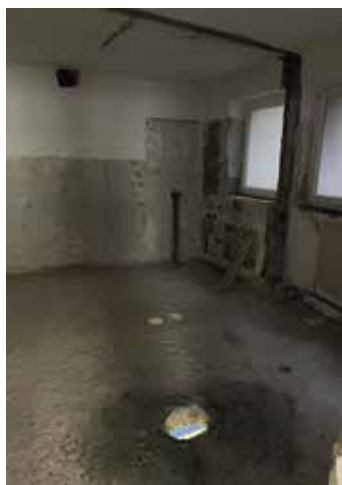
EG: alle WCs wurden entfernt
