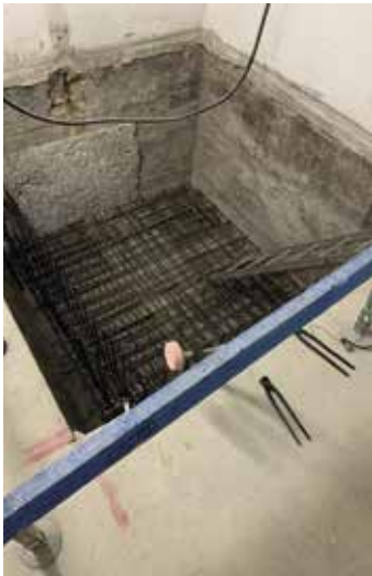
Keller: neuer Lift wird eingebaut
