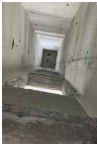
der alte Lift wurde entfernt
